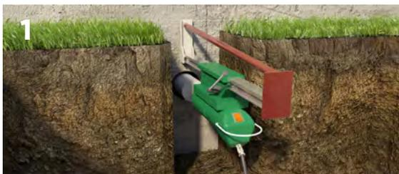
Алмазное сверление фундамента для прокладки канализационного трубопровода.
