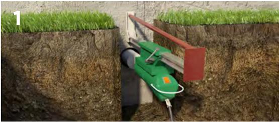
Алмазное сверление фундамента для прокладки канализационного трубопровода.
